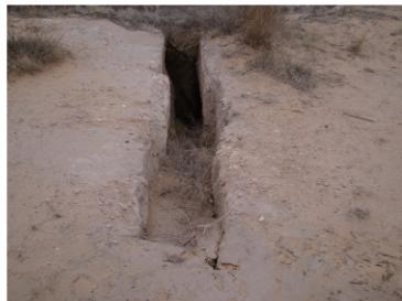
图2 工作面上部地表裂隙
